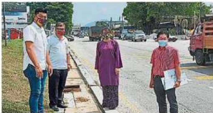
全長800公尺的無拉港路正在進行提升工程。左起為蘇仁強、林志遠、王詩棋及黃達強。
