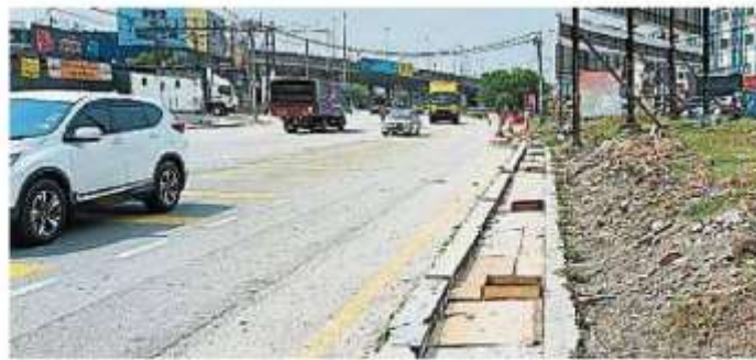
除了道路加寬，發展商也提升道路兩旁的排水道。
